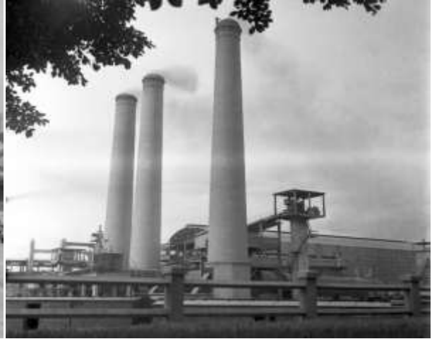
Figura 4: Chaminés da Companhia de Cimento Portland Itaú. Fonte: Acervo da Casa de Cultura Nair Mendes Moreira, 2015.
