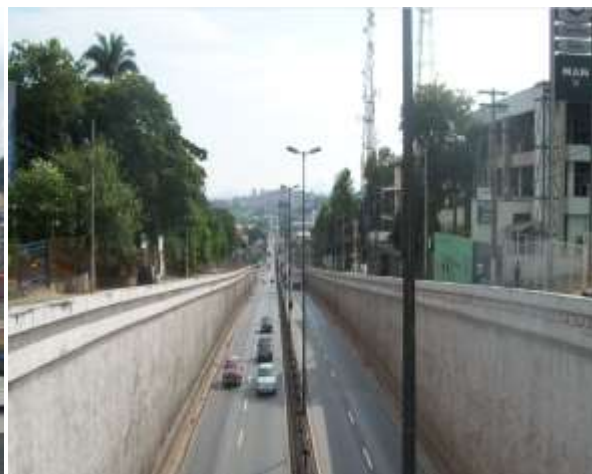
Figura 2: Avenida Cardeal Eugênio Pacelli na Cidade Industrial. Fonte: Flávio Moreira da Silva, 2015.
